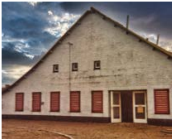
Figuur 8: Het gebouw van de NV Meral in 1976.
