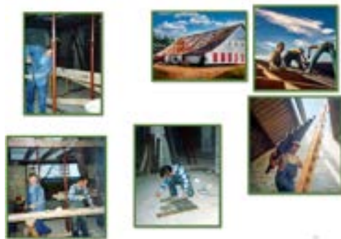
Figuur 10: De eerste werken om het gebouw geschikt te maken als maçonnieke werkplaats.
